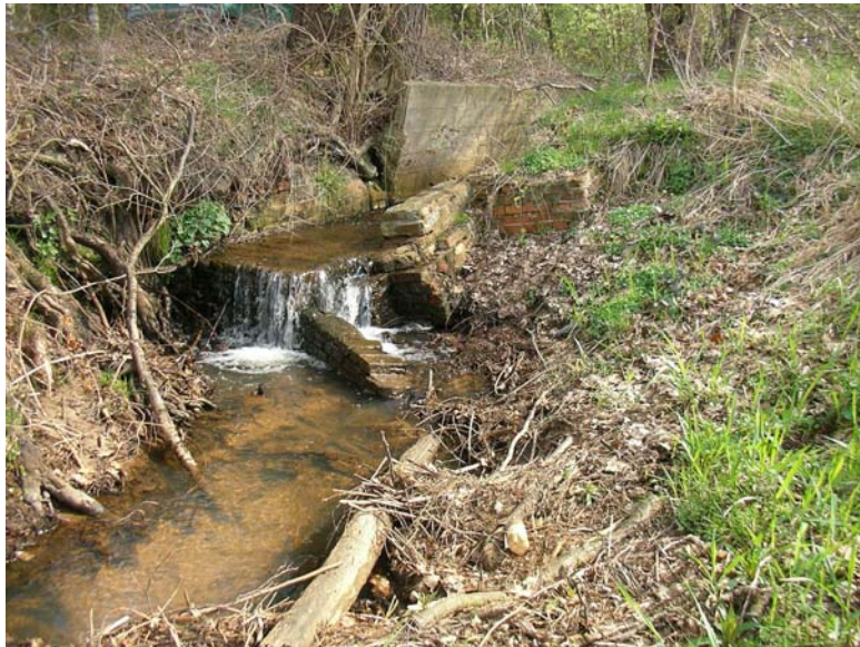
3.1. Erheblich veränderter Gewässerzustand: Krullsbach – Gewässerverbau, keine Durchgängigkeit
