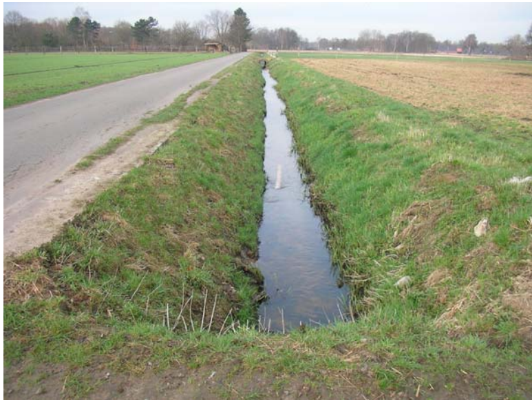
3.1. Erheblich veränderter Gewässerzustand: Kristerbach – Gewässerbegradigung, naturferne Uferbereiche
