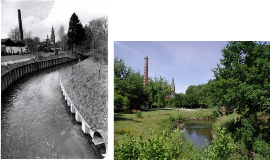
4.1. Renaturierte Gewässerabschnitte: Dalke - Alte Weberei, vor und nach der Renaturierung
