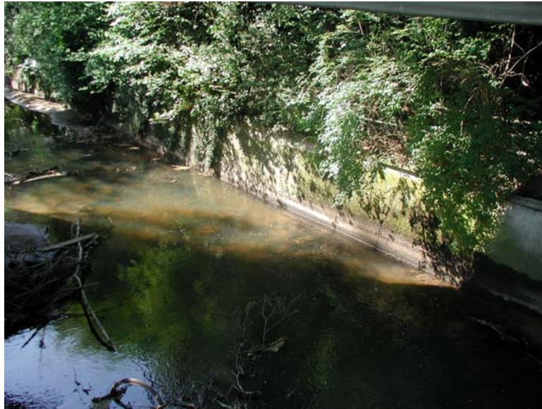
3.1. Erheblich veränderter Gewässerzustand der Dalke, Brücke Westring - Gewässerverbau
