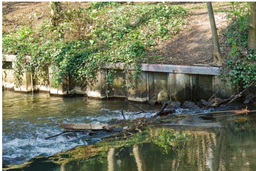
3.1. Erheblich veränderter Gewässerzustand der Dalke, Grünanlage Weberei - Spundwände
