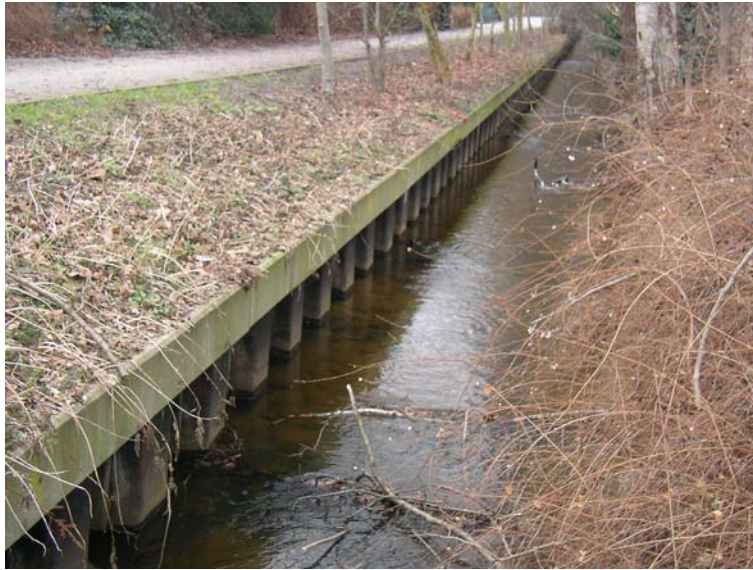
3.1. Erheblich veränderter Gewässerzustand: Schlangenbach – Begradigung und Uferverbau mit Spundwänden
