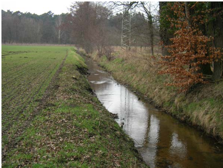
3.1. Erheblich veränderter Gewässerzustand: Knisterbach – Gewässerbegradigung, Regelprofil, standortferne Vegetation
