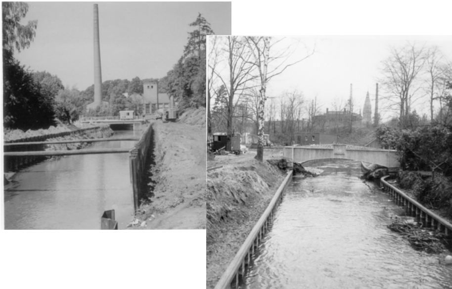
3.1. Erheblich veränderter Gewässerzustand der Dalke: Begradigung, Verbau mit Spundwänden ab etwa 1960
