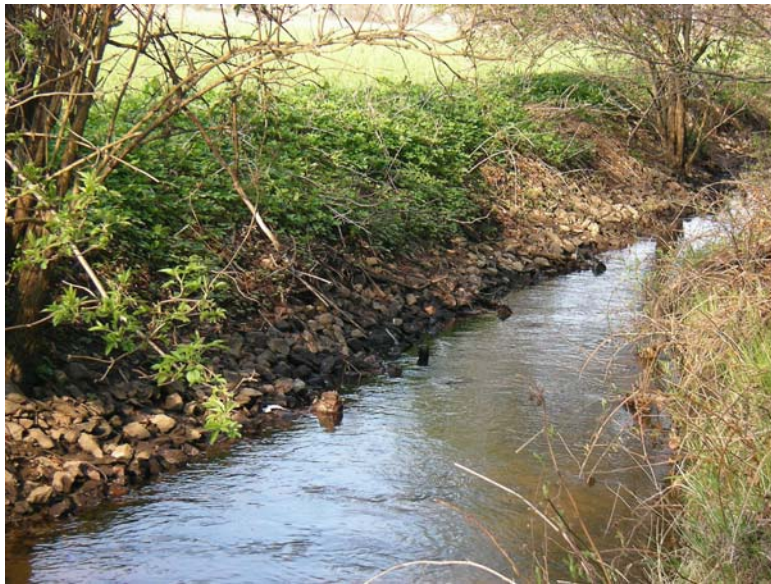
3.1. Erheblich veränderter Gewässerzustand: Schlangenbach – Regelprofil und Uferbefestigung
