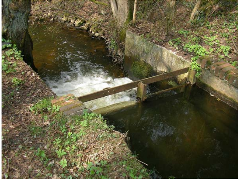
3.1. Erheblich veränderter Gewässerzustand: Lichte bach – Gewässerverbau, keine Durchgängigkeit
