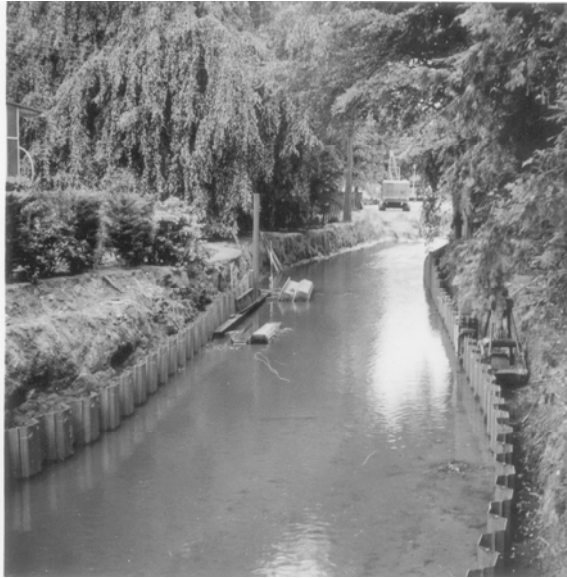
3.1. Erheblich veränderter Gewässerzustand der Dalke: Begradigung, Verbau mit Spundwänden ab etwa 1960
