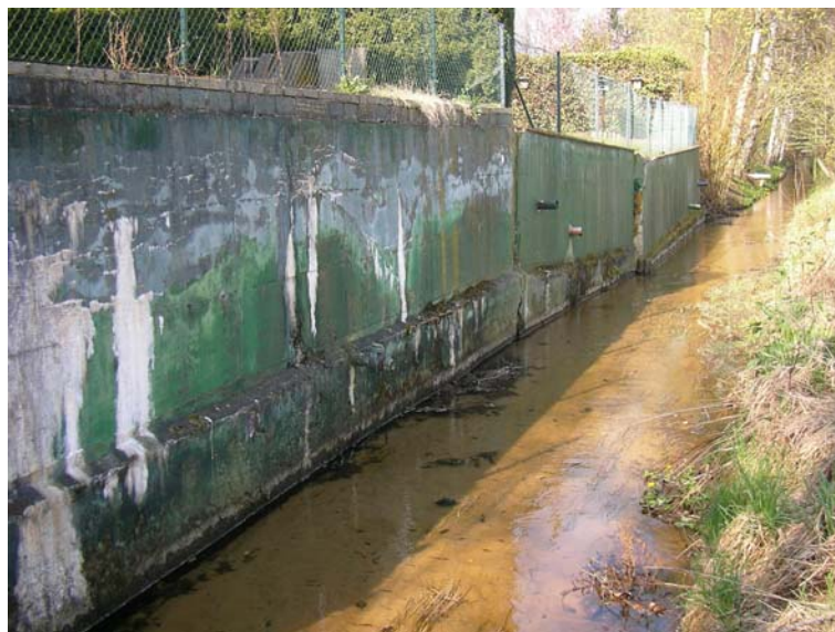
3.1. Erheblich veränderter Gewässerzustand: Reinkebach, Am Schling - Uferverbau
