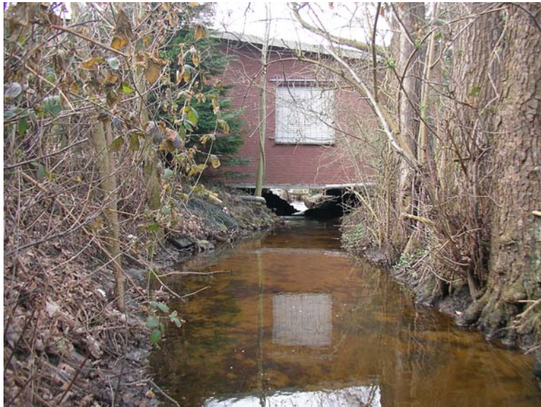
3.1. Erheblich veränderter Gewässerzustand: Schlangenbach, Hülsbrockstraße – Überbauung
