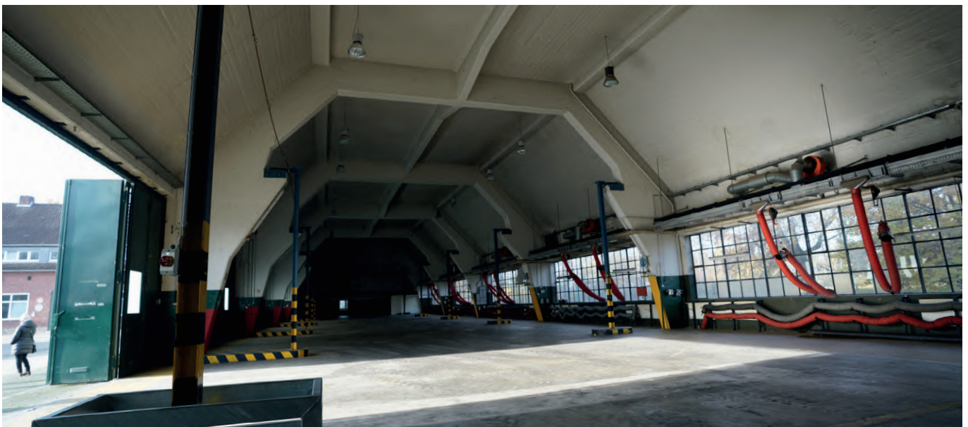
Die Panzerhalle von Innen im Nordwesten des Plangebietes
