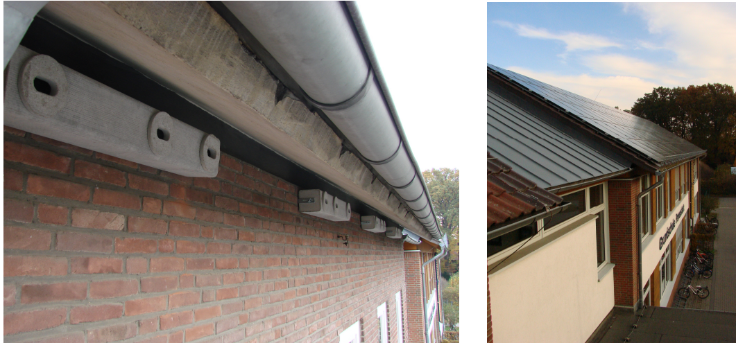
Die Grundschule Pavenstädt kann auch Artenschutz: neben den Photovoltaikflächen auf dem Dach (rechts) zieren eine Etage tiefer jetzt auch Mauerseglerquartiere die Dachtraufe des Mitteltrakts (links). Foto: Stadt Gütersloh
