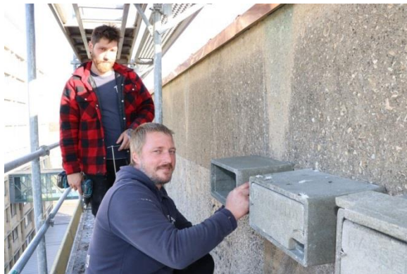
(Anbringen von 15 Nistkästen für Mauersegler und 4 für Fledermäuse bei der Dachsanierung des Gütersloher Rathauses)
