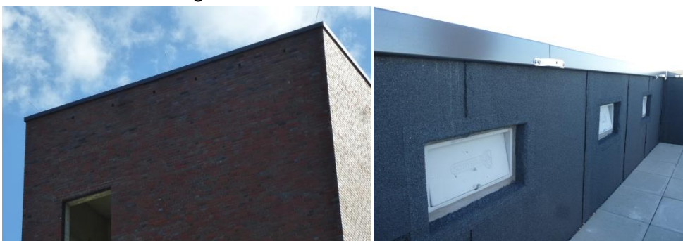
(Mauerseglerquartiere im Neubau der Feuerwache Gütersloh)
