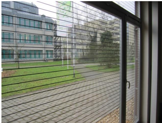
(Vogelschlagsicherung an der Natur- und Umweltschutz-Akademie NRW, Recklinghausen Foto: Peter Herkenrath, LANUV NRW)
