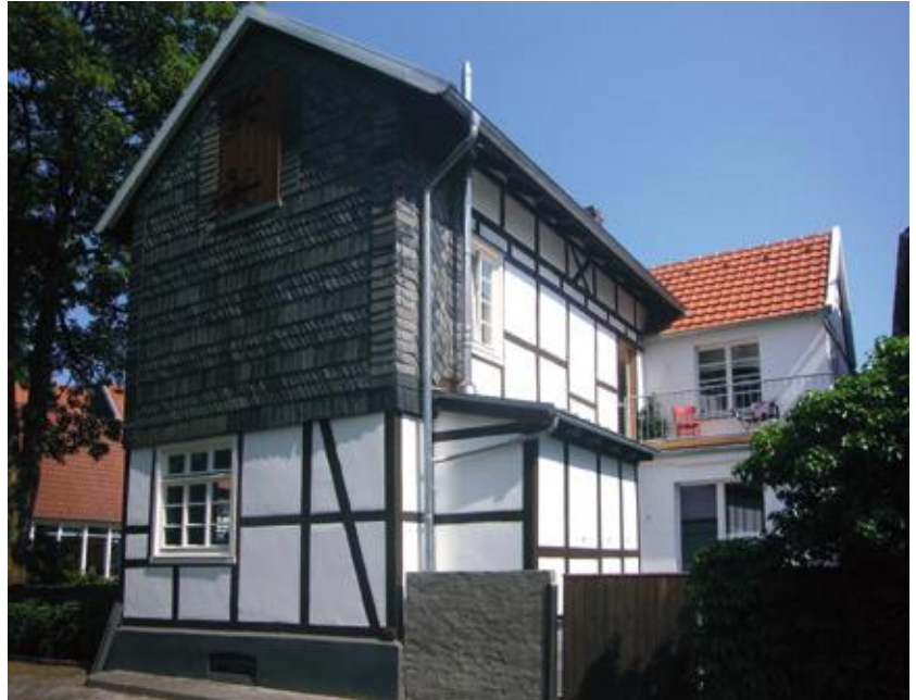
Hofbereich Lange Straße 35 a | Rheda-Wiedenbrück
