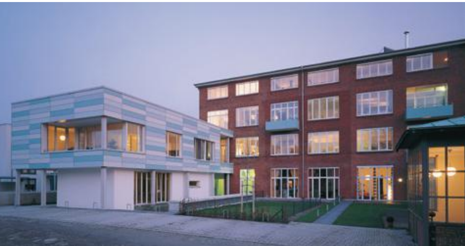
Umbau und Erweiterung eines Verwaltungsgebäudes zu Lofts | Gütersloh
