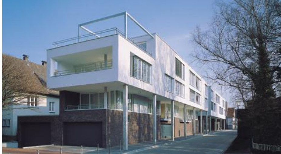
Überbauung Zufahrt einer Tiefgarage an der Daltropstraße | Gütersloh
