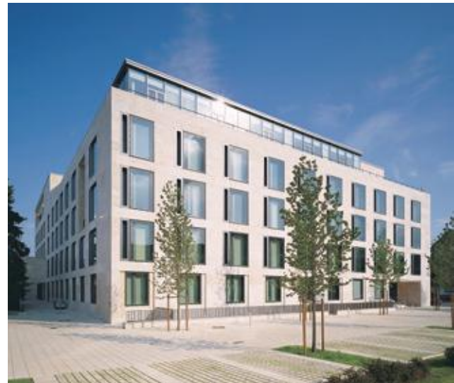
Volksbank-Zentrale . Rückansicht | Gütersloh
