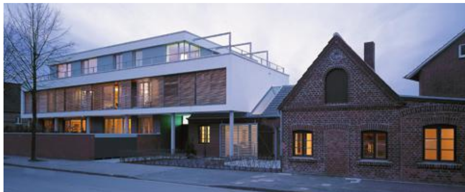
Wohnungsbau und Sanierung der alten Schmiede | Gütersloh
