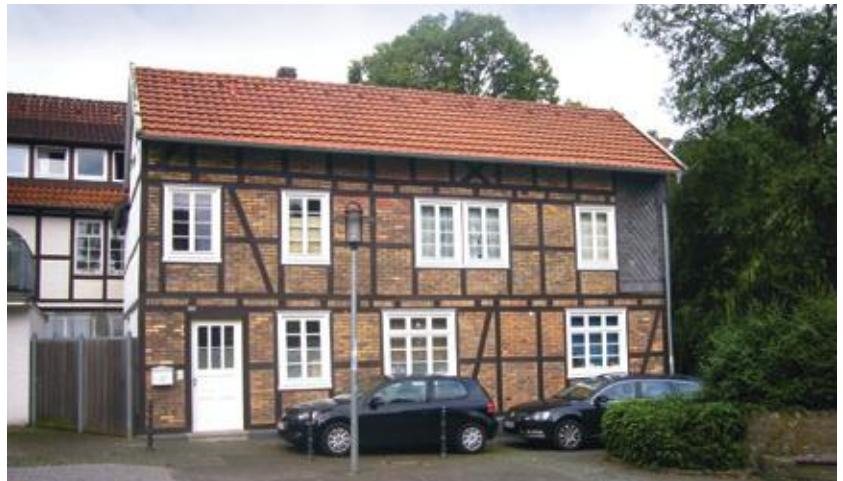
Lange Straße 35 a | Rheda-Wiedenbrück
