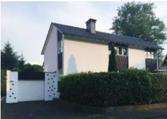
Wohnhaus . Baujahr 1956 | Gütersloh. Durch Initiative des Heimatvereins 1996 eingetragen in die Denkmalliste.
