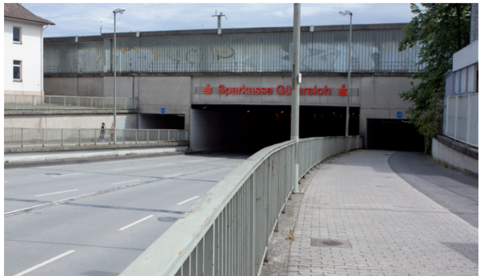
Bild D1: Unterführung Friedrich-Ebert-Straße
