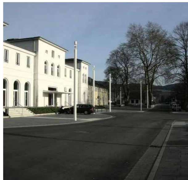
Abb. 26: Bahnhofsgebäude nach der Sanierung
