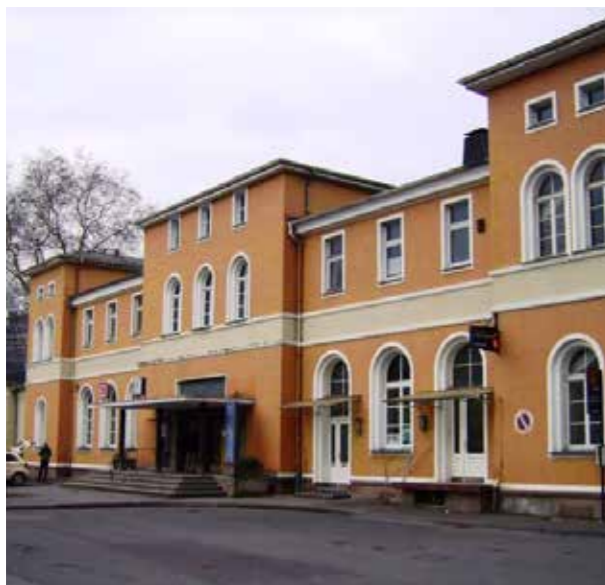
Abb. 25: Bahnhofsgebäude vor der Sanierung
