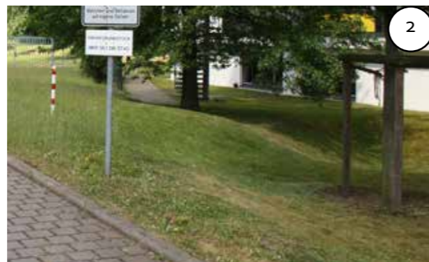
2) Regenmulden auf dem Gelände der Medienfabrik
