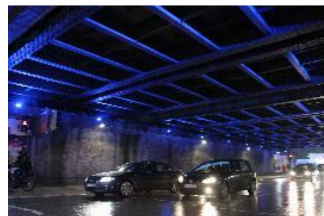
Stohlmannplatz (oben) Unterführung Lindenstraße
