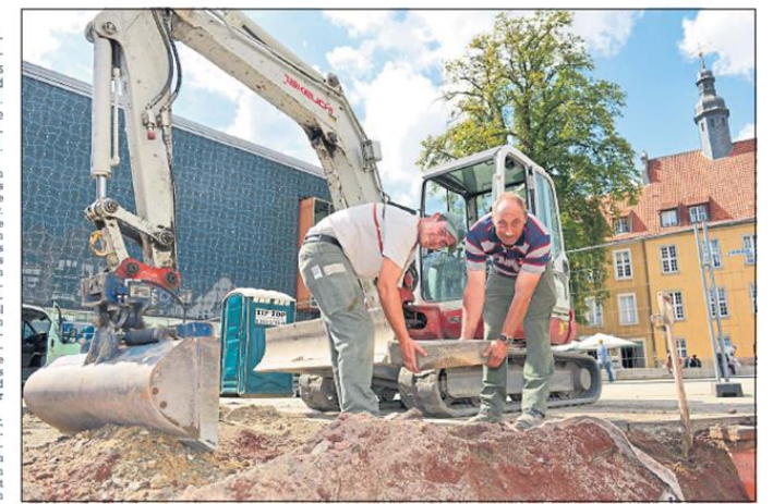
Marcel Vorholt (links) und Martin Ruhose heben den portugiesischen Pflasterstein auf dem Berliner Platz an. An dieser Stelle wird bis
