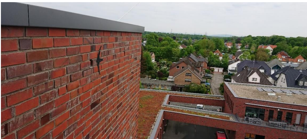
Die Mauerseglersilhouette zeigt den Mauerseglern den Eingang zu einem der Nistkästen
