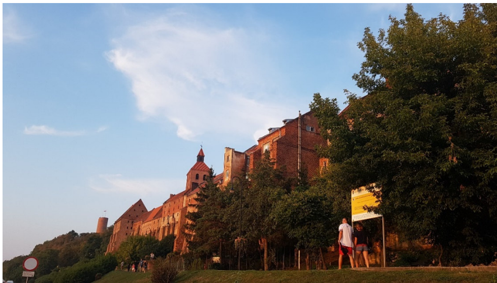
Stadtmauer von Grudziądz
